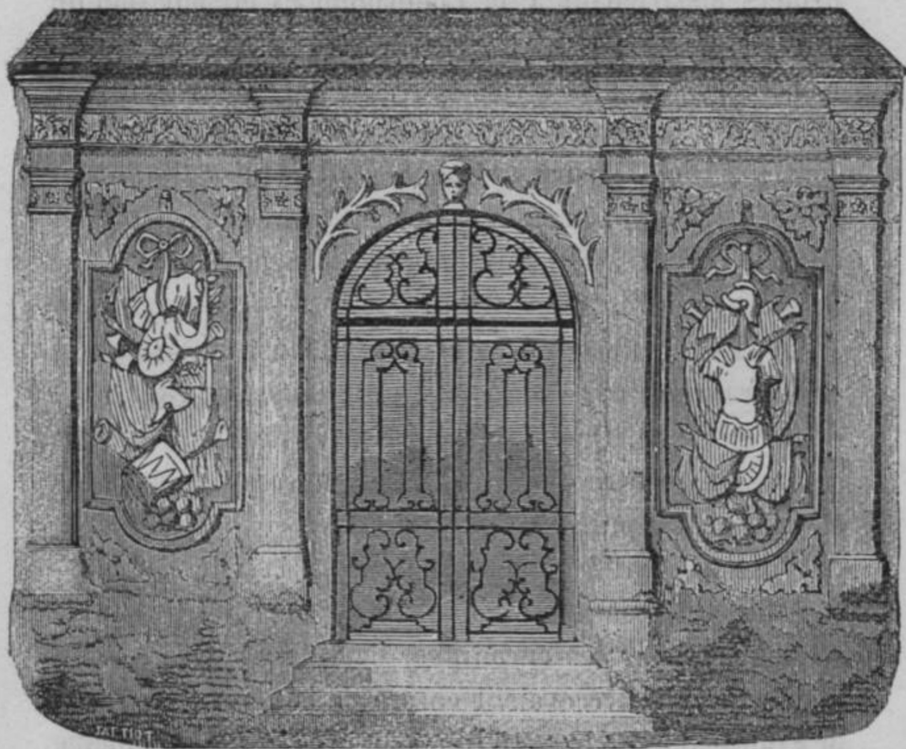
PORTE DE L'ANCIEN HÔTEL DES CANONNIERS DE SAINT-QUENTIN (état actuel).
